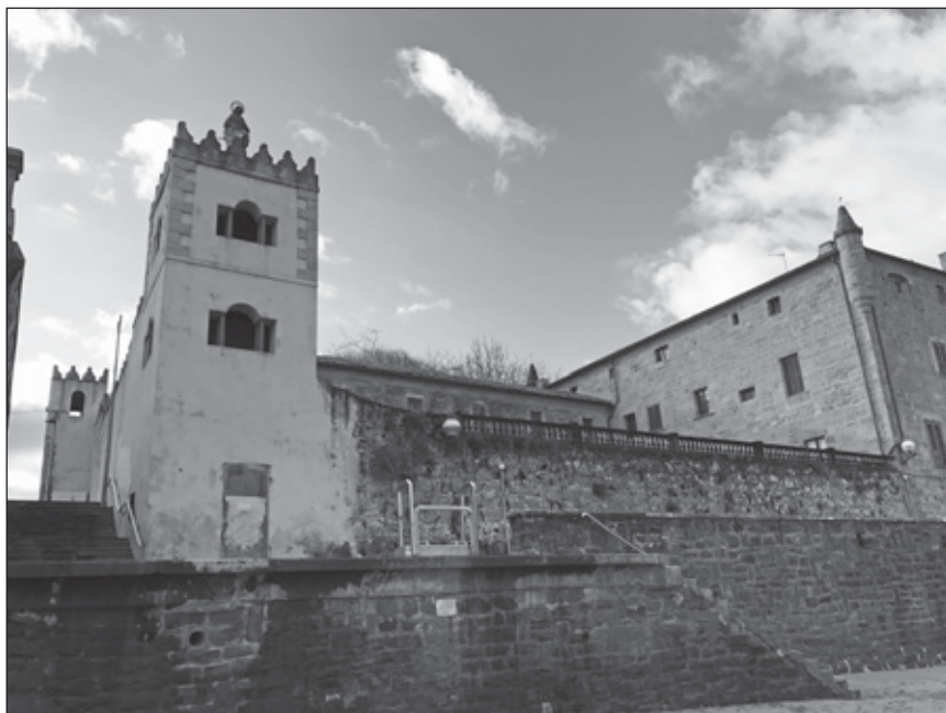
Fig. 16. Palacio de Narros desde la playa con el edificio que albergaba la gruta o vestuario y lugar que ocupó el jardín, actualmente sin vegetación arbórea de altura. Zarauz, diciembre de 2020. Fot. autora.
