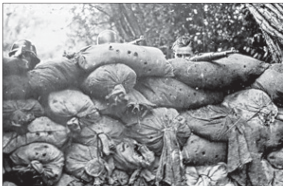
Fig. 9. Trincheras en Polloe.
