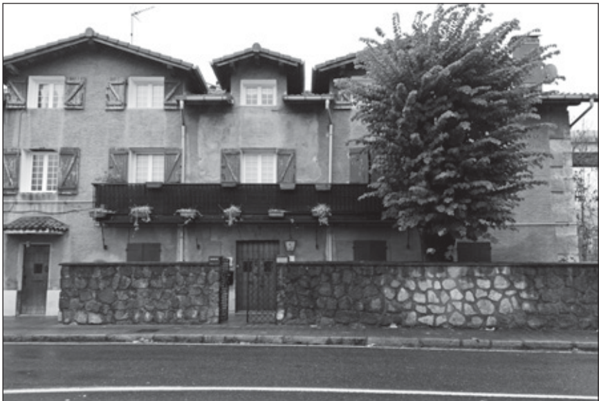
Casa de Pablo Carrese en Tolosa. (Existente actualmente).
